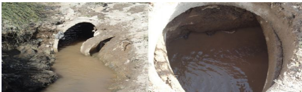
شکل (۳): گرفتگی قنات طوغان باباگرگر در اثر رسوبات ناشی از سیل
