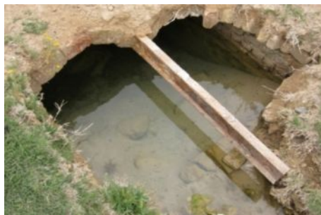
شکل (۷): نبود سازه های مناسب بعد از مظهر قنات
